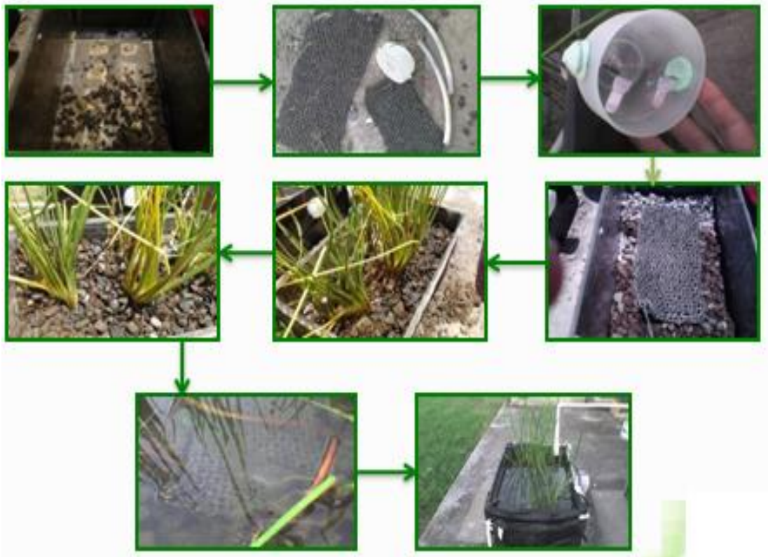
Figura 18. Diagrama fotográfico de la construcción de los humedales artificiales.
